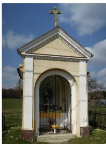
Farkasfa, Fővég u. 2-6.
